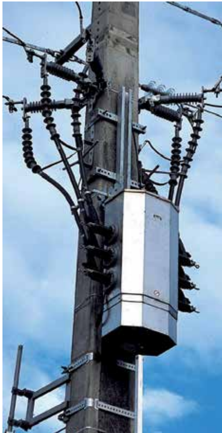
Condamnation de l'interrupteur de neutralisation
