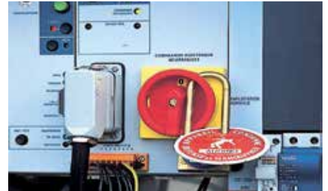
Condamnation de l'interrupteur de neutralisation
