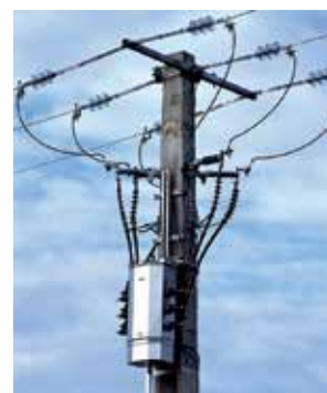
AUGUSTE installé sous la ligne
