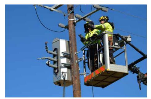
La caja de control y mando comercializada con la solución Auguste tiene por función controlar y accionar a distancia o de modo local el interruptor Auguste, en función de las necesidades del cliente.
