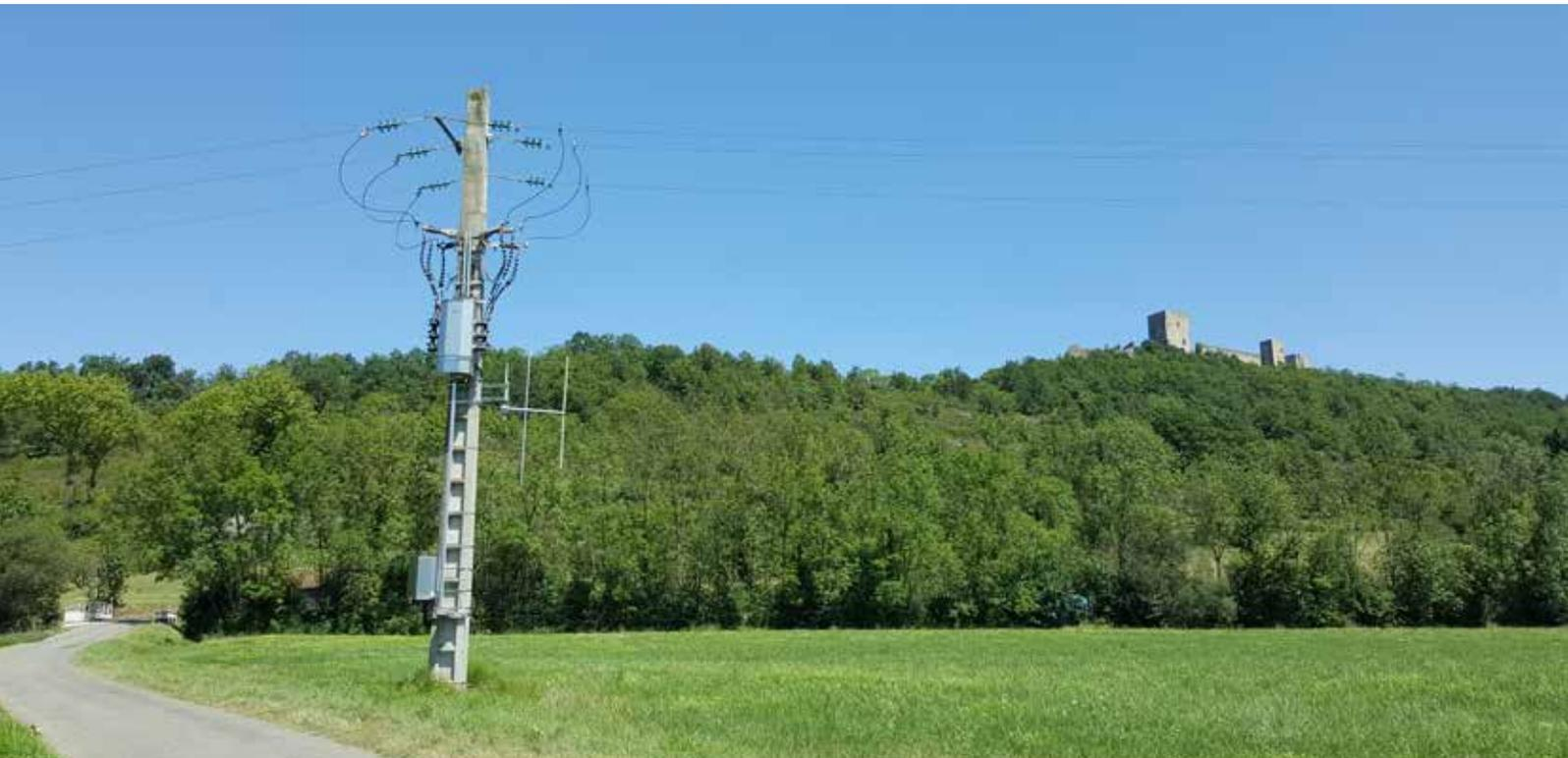
Cette gamme de coffrets Contrôle Commandes commercialisée par Ensto a pour fonction de contrôler et de commander à distance ou en local des organes de coupure MT.
