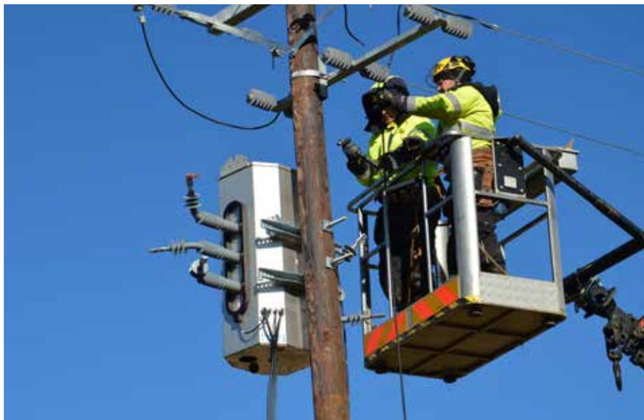
Le coffret de contrôle commande commercialisé avec la solution Auguste a pour fonction de contrôler et commander à distance ou en local l'Auguste en fonction du besoin client.
