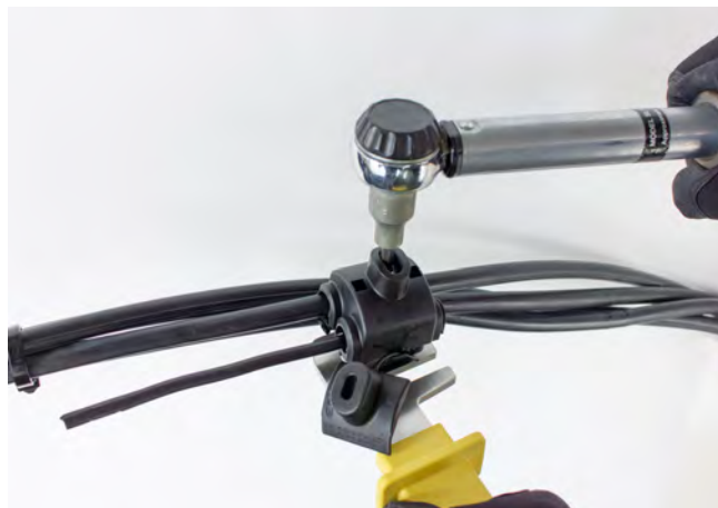
Dokręcanie zacisku SL11.118 za pomocą klucza dynamometrycznego.
