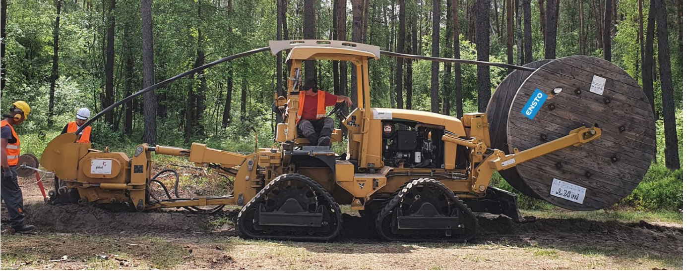
Układanie kabla AXAL-TT PRO pługiem wibracyjnym
