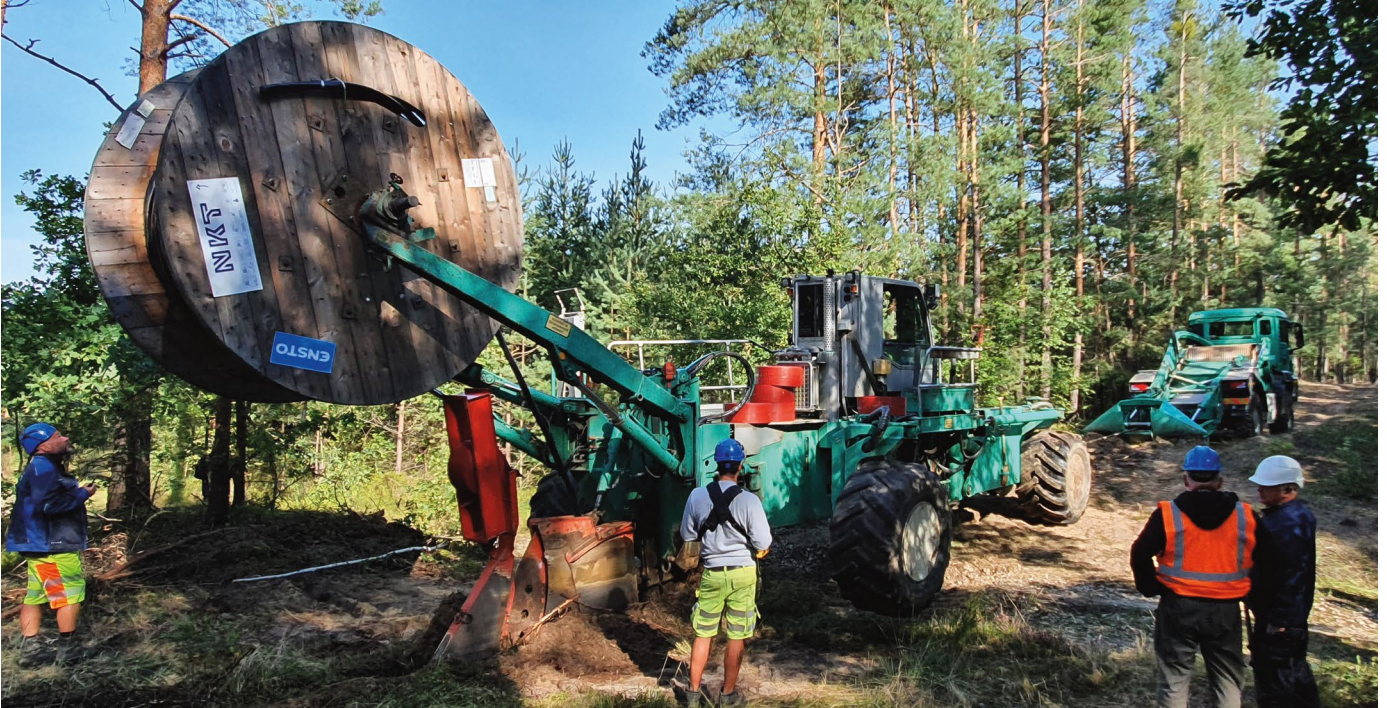
Układanie kabla AXAL-TT PRO pługiem ciągnionym
