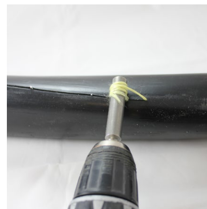
Linki z włókna kevlarowego umieszczone wewnątrz kabla ułatwiają przecięcie i usunięcie powłoki zewnętrznej
