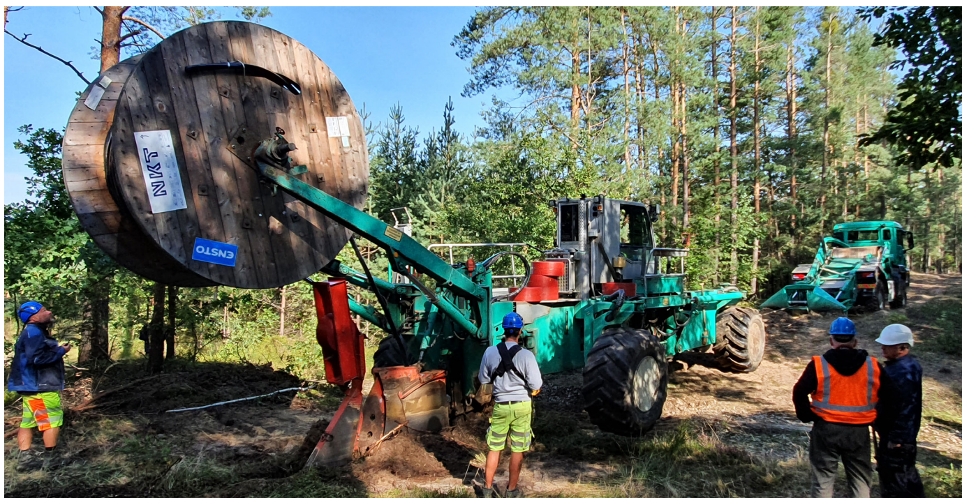
Układanie kabla AXAL-TT PRO pługiem ciągnionym
