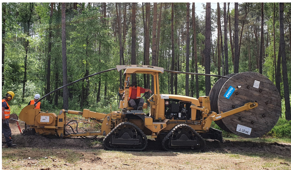
Układanie kabla AXAL-TT PRO pługiem wibracyjnym
