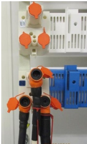
Prises de réalimentation TIPI 8-1800 pour le NEUTRE
