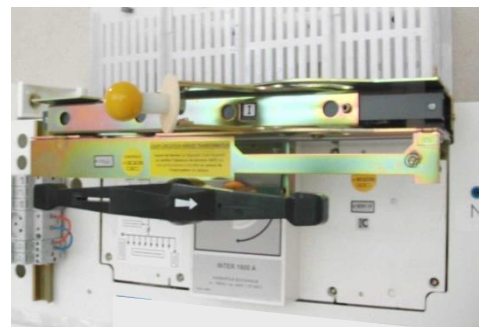
Interrupteur OUVERT Court-circuiteur FERME
