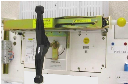
Interrupteur FERME Court-circuiteur OUVERT
