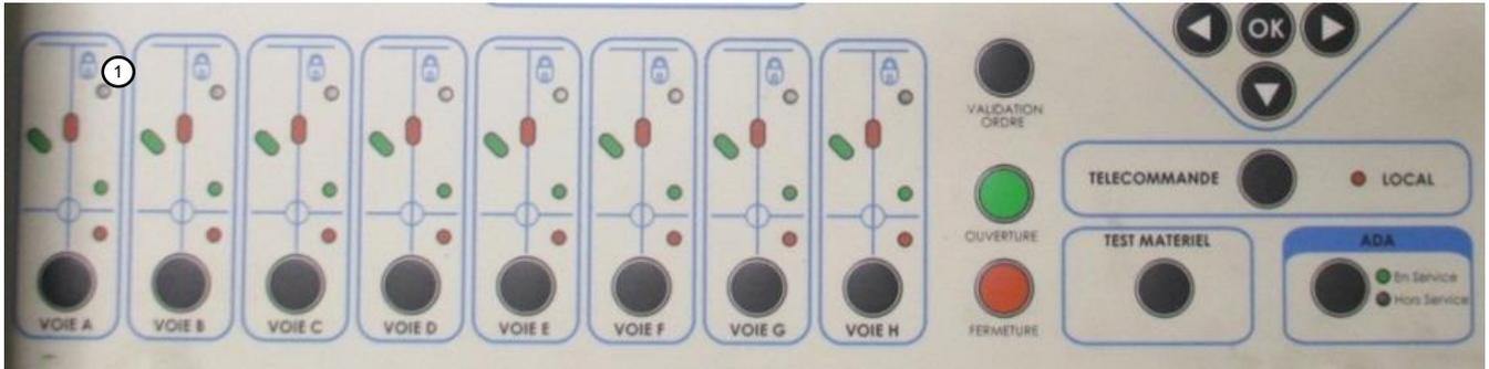
Pour réaliser une commande de fermeture, dans un premier temps sélectionnez la voie à manœuvrer, puis appuyez simultanément sur les boutons "FERMETURE" et "VALIDATION ORDRE". Après la fermeture le voyant rouge de position s'allume
